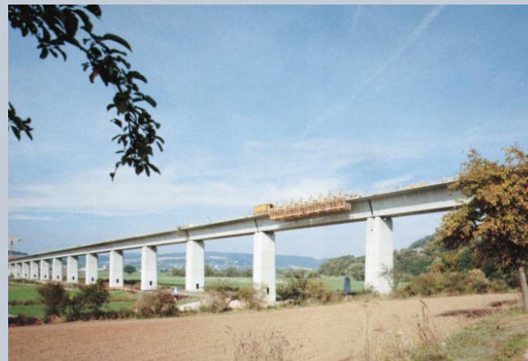
Fulda-Talbrücke Solms, Germany
